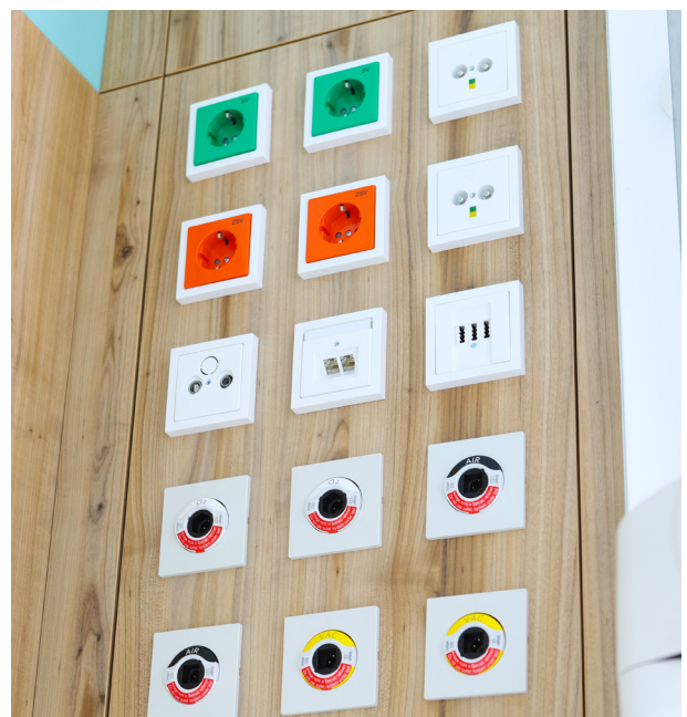
Anschlussmöglichkeiten für Strom, Medizinlgase und Medien
